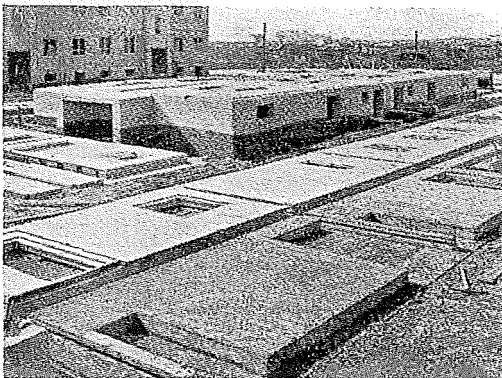
Opførelse af Rækkehuse efter Occident-Metoden.
